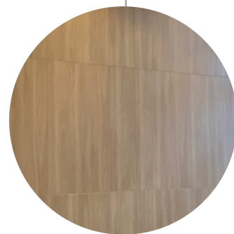
Pórtico revestido com placas de madeira
